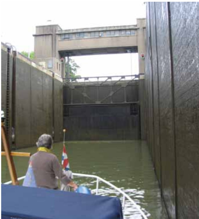
8,5 meter diep in de sluis bij Born.
