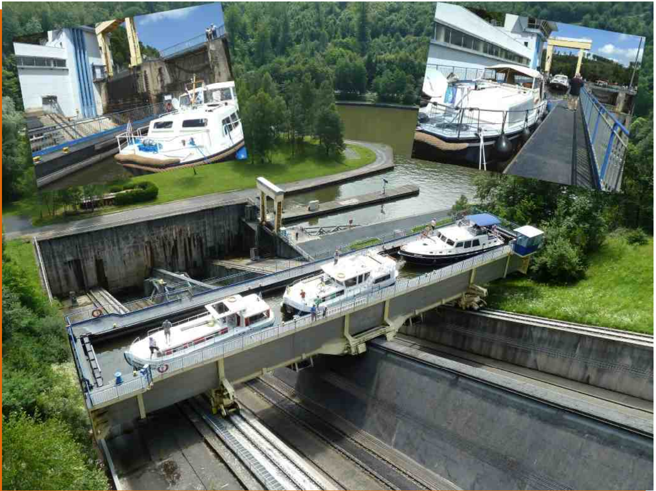
De schepenlift van Arzviller in het Canal de la Marne au Rhin. Hoogteverschil : 43 meter, met inzetten van de 'liftende' Doerakken 950PAV Los Harmanos van Pim en Door Frequin (linksboven) en de 850AK Roger van Gerard en Edith Langerak (rechtsboven)
