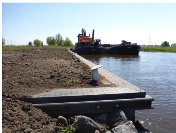
De Kaai (SN 58) met nieuwe betonnen damwanden met KLP-gordingen en dekplanken
